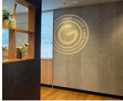
火力発電所で発生する石炭灰、使用済みのコーヒー豆などの廃棄物を再利用したリサイクル資材を使用
